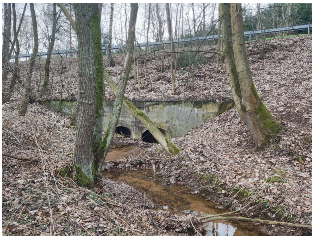
Obrázek 1-7: Propustek pod silničním tělesem
