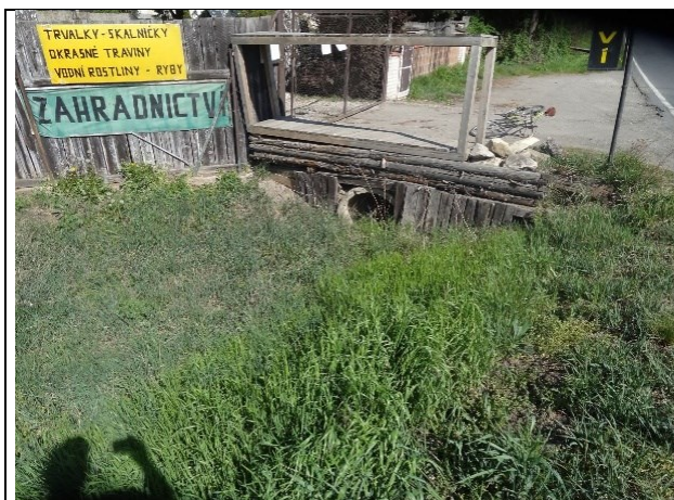
obr. 1 - Propustek pod sjezdem (DN800)
