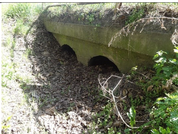
obr. 2 - Propustek pod silnicí (2xDN800)
