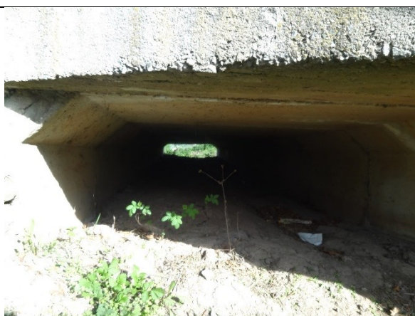
obr. 4 - Částečně zanesený propustek sedimentem pod silnicí silnice II/113
