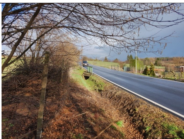
obr. 3 - Příkop a propustek u silnice II/113
