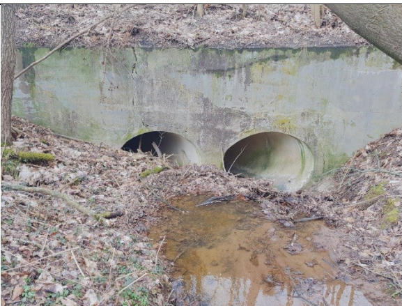
obr. 3 - Částečně zanesený propustek na Bušinci přes silnici II/113
