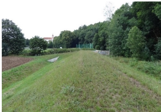
Zemní protipovodňová hráz
