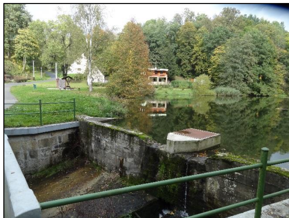
obr. 1 - Fotodokumentace nevhodného objektu na hrázi vytvářejícího potenciální ohrožení hráze
