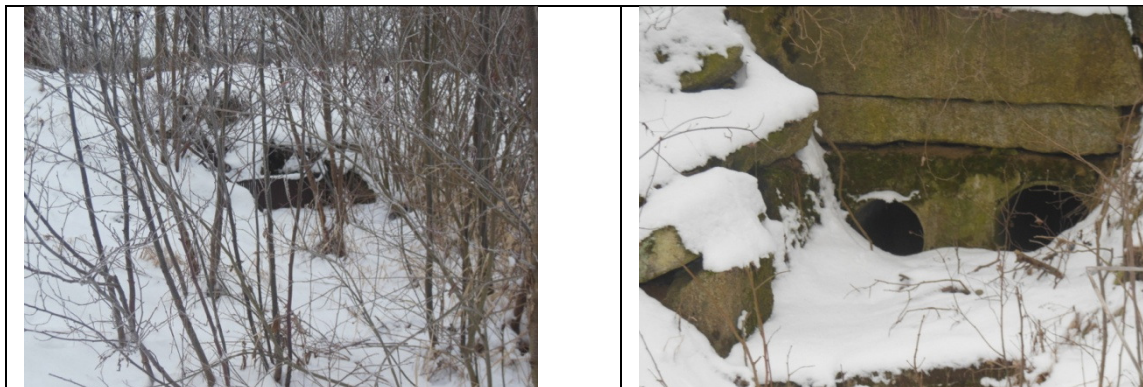
Obr. 28 Pohled 1a a 1b – bezpečnostní přelivy jsou řešeny jako trubní propusti vedené skrz těleso hráze, na návodní straně jsou opatřeny česlemi
