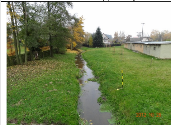
Obr. 11 Pod soutokem Odolenovického a Útvinského potoka potoka - foto 3
