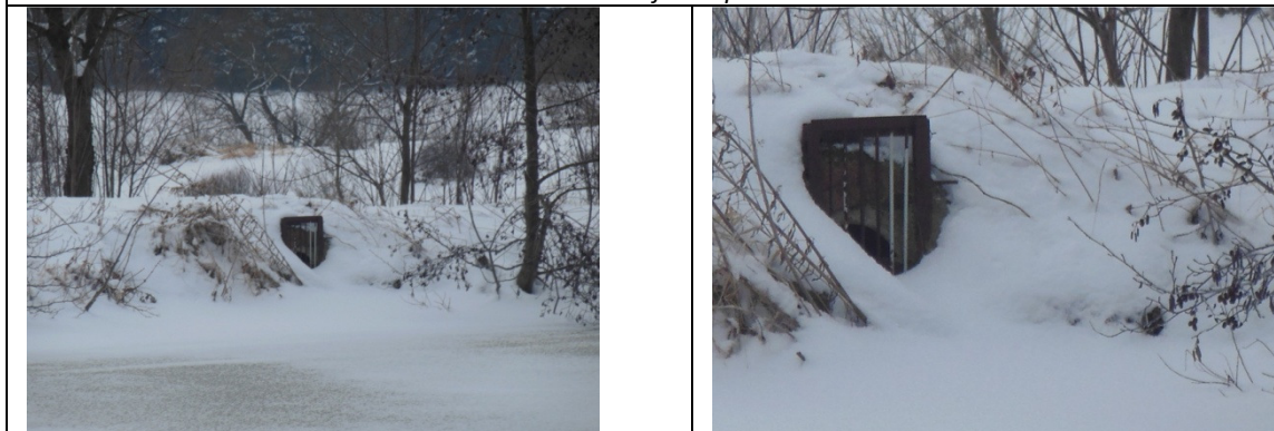
Obr. 29 Pohled 2a a detail - horní hrana česlí dosahuje téměř ke koruně hráze
