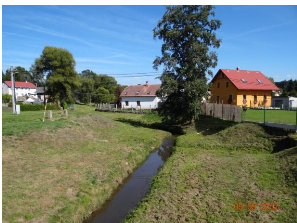
Centrum Útviny - koryto je v intravilánu udržované.
