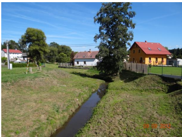
Centrum Útviny - koryto je v intravilánu udržované.
