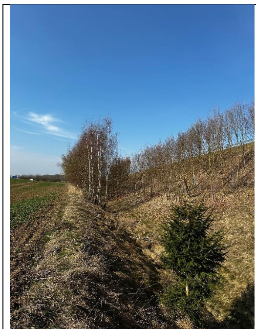
Pohled na svod směrem do povodí KB
