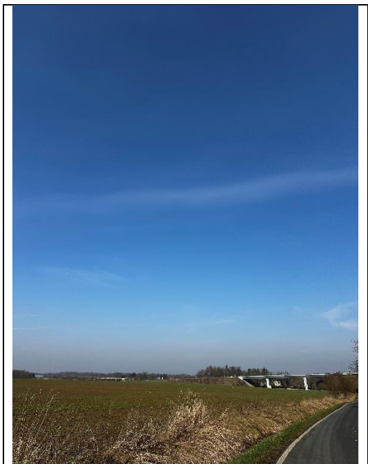
Pohled na KB od místní části obce Štědrá
