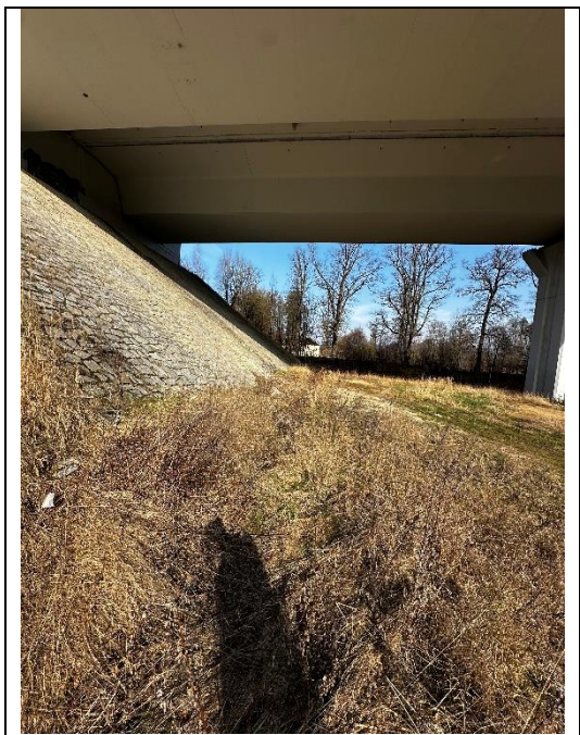
Pohled na KB pod mostem dálnice D6
