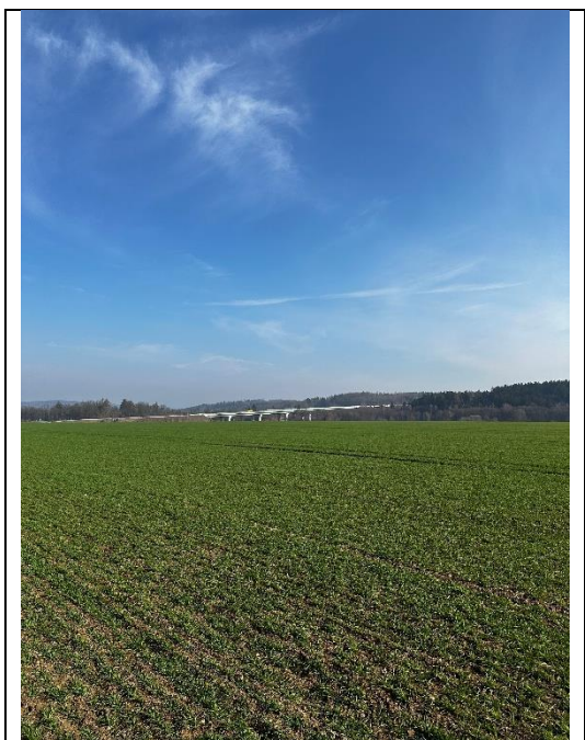
Pohled směrem od silnice III/2125 na dálnici D6, přilehlou ornou půdu a KB
