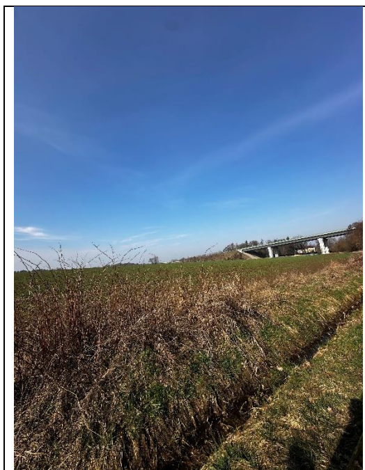
Pohled na KB a dálniční most ze silnice III/00632
