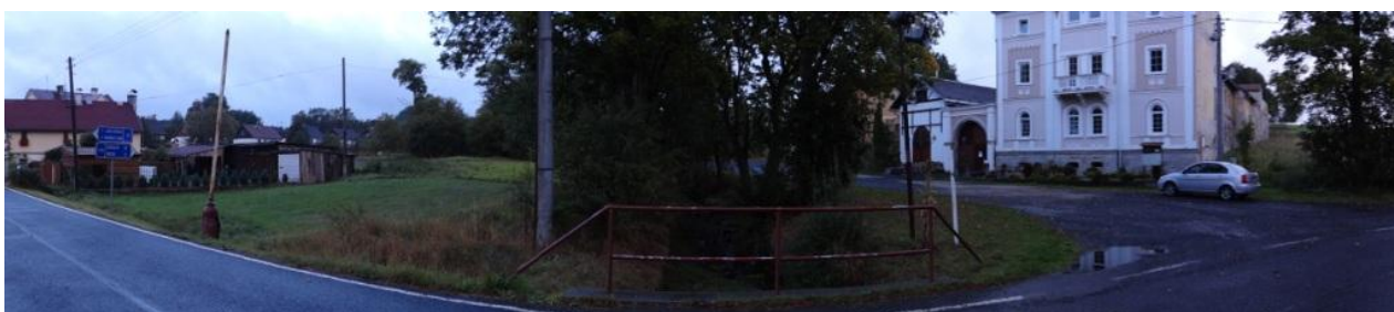
Celkový pohled na ohroženou lokalitu u obecního úřadu.
