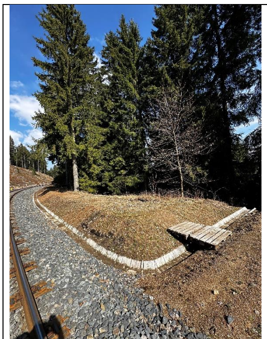
Svod povrchových vod ze železniční trati do lesa směrem ke KB
