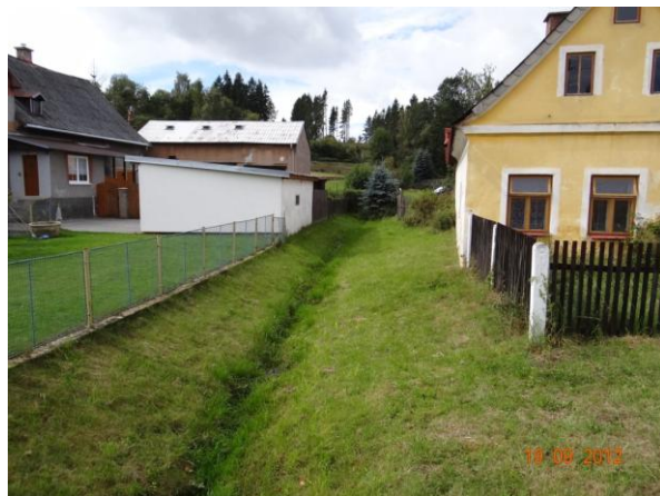
Koryto mezi č.p. 90 a 91.
