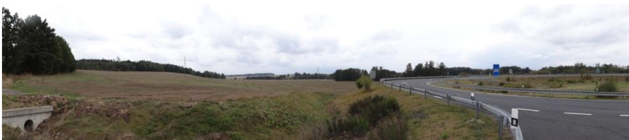
Celkový pohled na dálniční kříž pod areálem Jatek.
