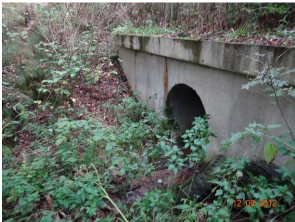
Trubní propust v tělese příjezdové komunikace.
