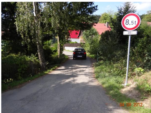
Přístupový most k lokalitě Oldřichov a k RD.
