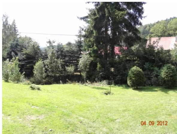
Koryto Limnice podél obytné zástavby, která bude ohrožena.
