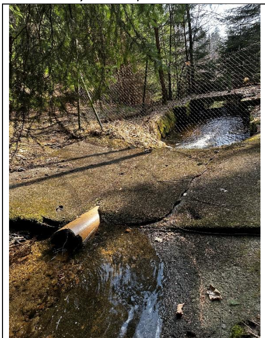
Propustek a přeliv vodního toku nad zastavěným územím
