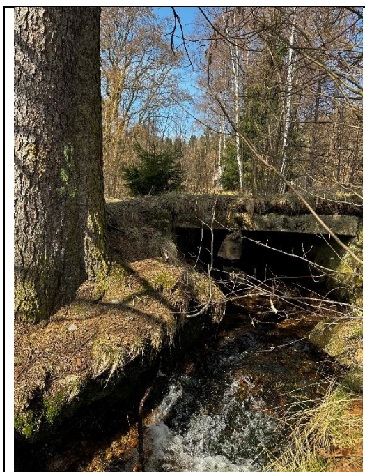
Propustek pod místní komunikací
