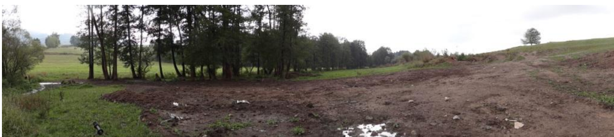
Celkový pohled na trasu odtoku z přerušeno náhonu.
