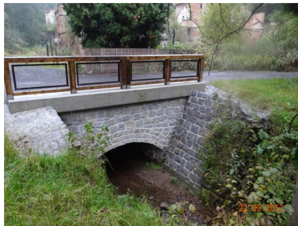
Nově rekonstruovaný most 21030 a-1.
