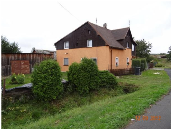
Ohrožený objekt č.p. 86. s propustky v příjezdu.
