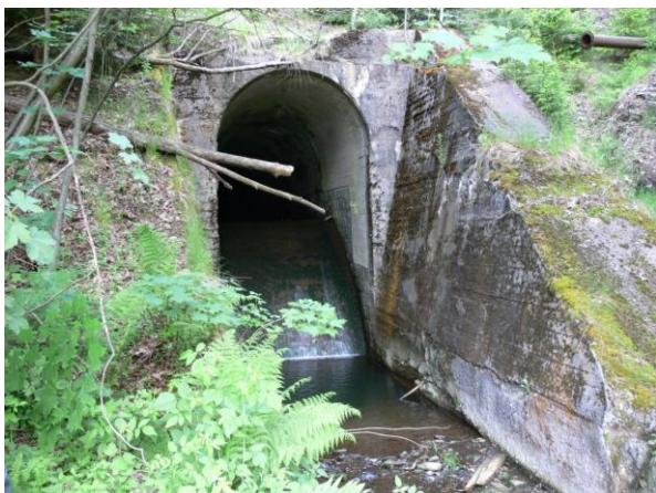
Krytý profil toku pod haldou.
