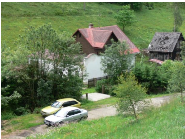
Ohrožená nemovitost č.p. 160 nad kritickým bodem.
