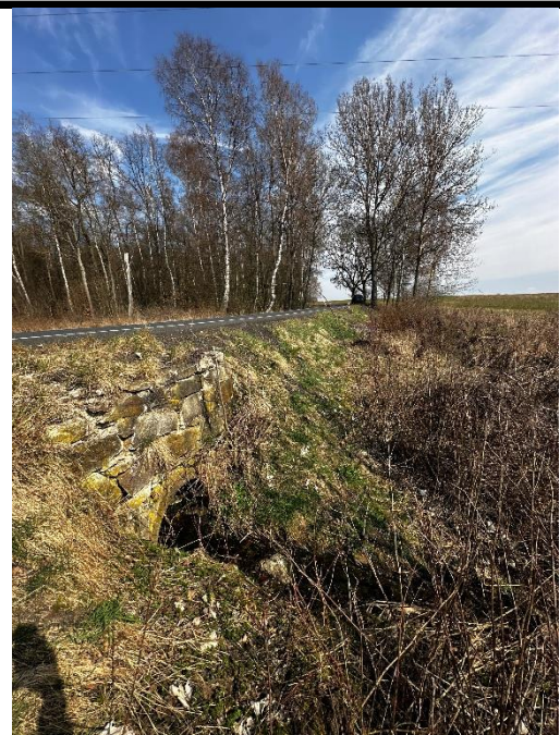
Propustek pod silnicí III/22128
