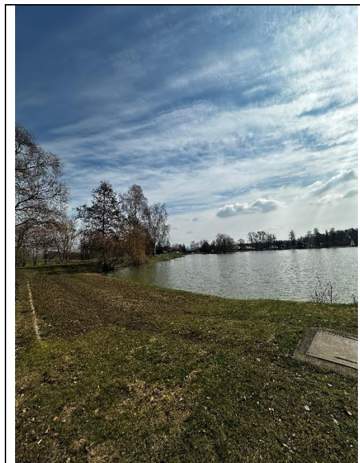
Pohled směrem pod KB na vodní plochu Kfelský rybník a její bezpečnostní přepad
