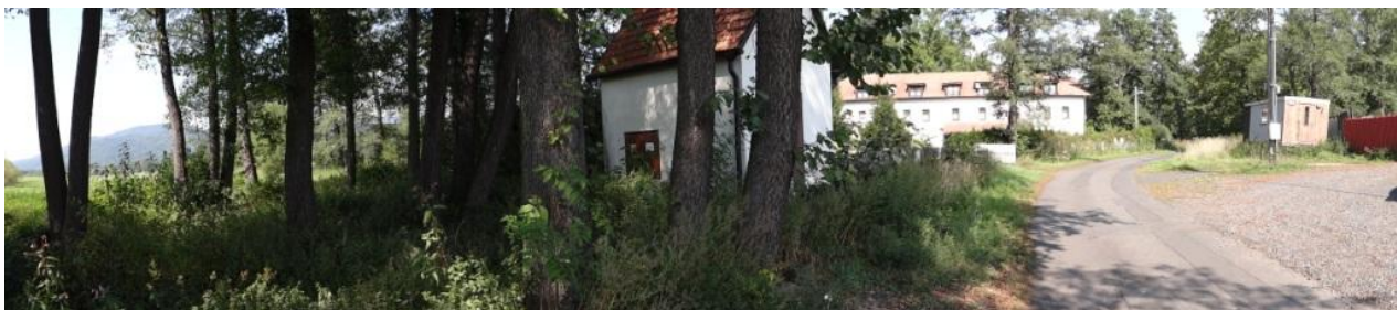
Obtok trafostanice nad Mlýnem.
