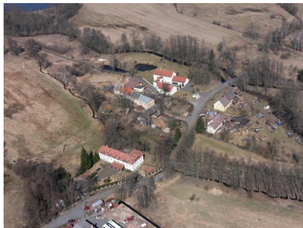
Ohrožená trafostanice, Mlýn a areál S.V.I Rubikon.
