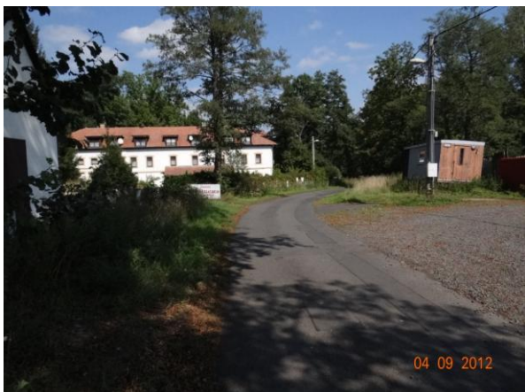
Ohrožený objekt penzionu Mlýn (v současné době k nevyužívání a k prodeji).
