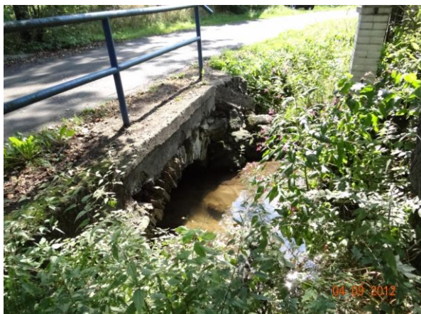
Kamenný klenbový mostek pod Mlýnem - kritický profil pro rozliv na komunikaci a do Mlýna.
