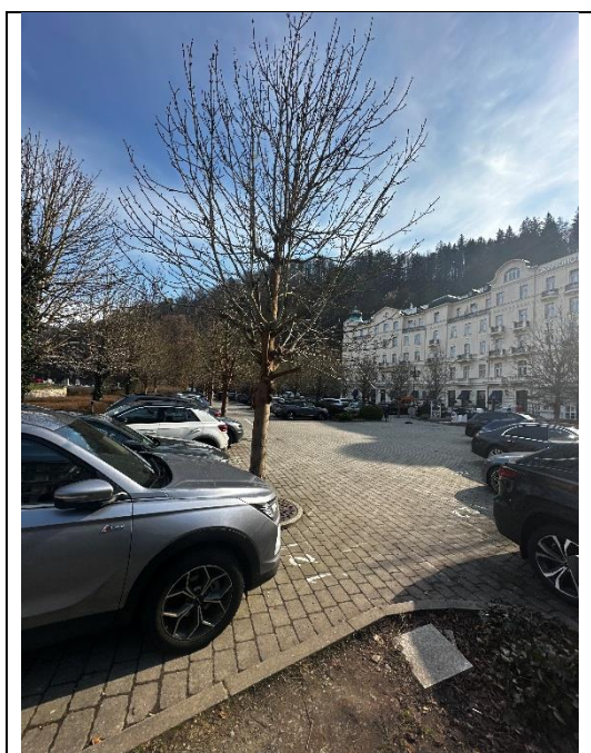
Zpevněné plocha parkování před Hotelem Pupp, bez možnosti infiltrace povrchových vod do zeleně (snížení obrubníků)
