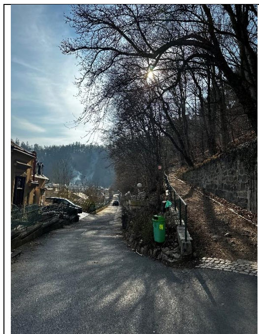
Pod Jelením skokem – místo, kde se může dostávat cizí voda do zastavěného území
