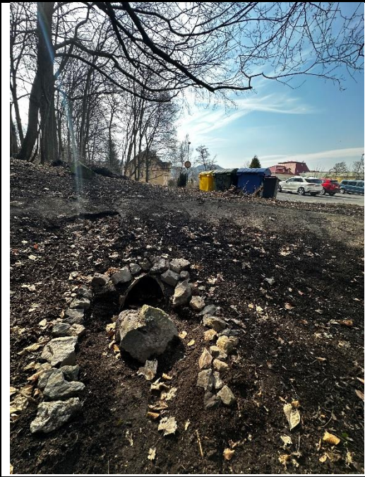
Nekapacitní propustek pod komunikací
