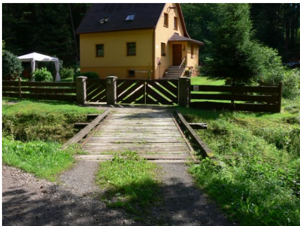
Objekt č.p. 154 - první ohrožený objekt pod kritickým bodem.
