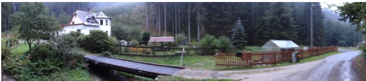
Celkový pohled na ohrožené objekty pod kritickým bodem v lokalitě Háj.
