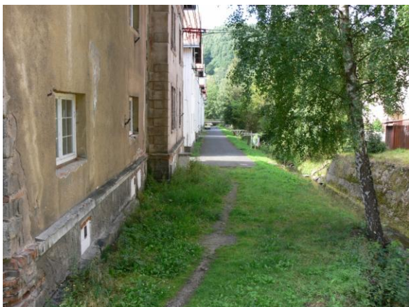
Ohrožené bytové domy v lokalitě Nové Hory.
