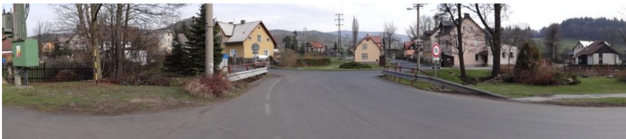
Centrum obce s mostem 2204-1, ten bude pravděpodobně přelit a dojde k významnému omezení dopravy.
