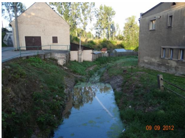
Koryto podél objektu č.p. 204 a 203.
