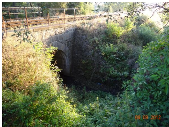
Železniční most u kritického bodu, první místo záchytu splávní.
