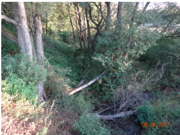
Neudržované koryto toku nad kritickým bodem.
