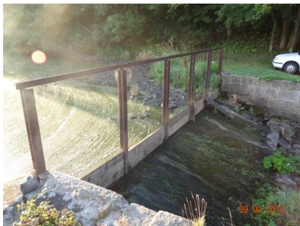
Částečně hrazený bezpečností přeliv Křížového rybníka.
