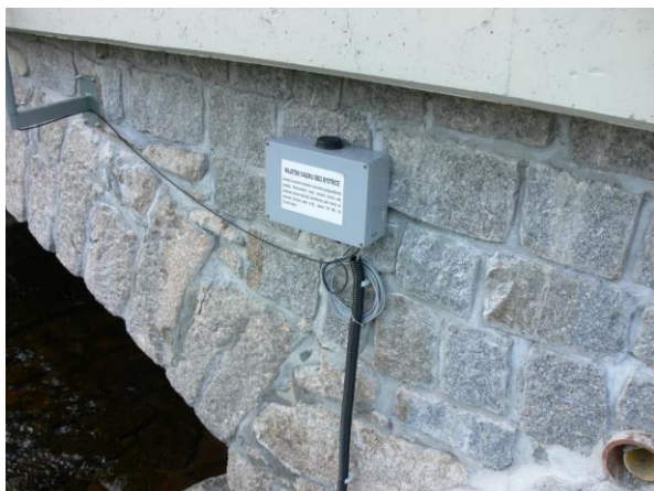
Hlásný profil Svazku obcí Bystřice v ř.km 23,55 na mostu 219-013 u č.p. 121.
