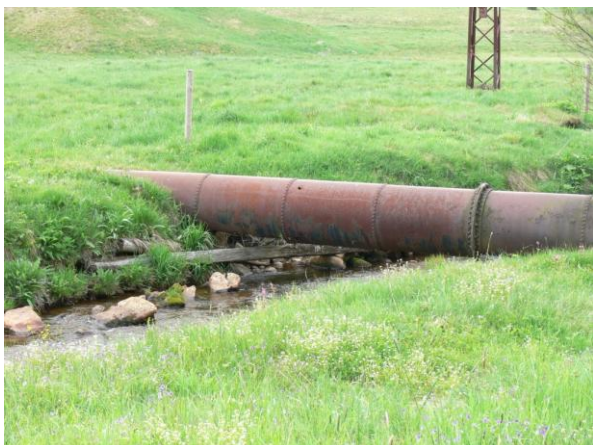
Historická ocelová trouba v korytě pod kritickým bodem, účel na OÚ nezjištěn.
