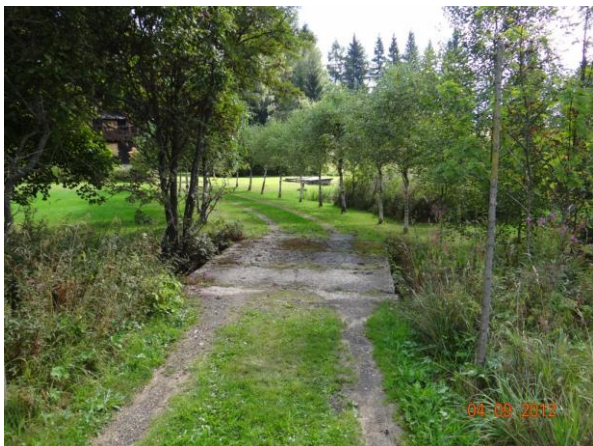
Přístupový mostek k nemovitostem č.p. 67 a 72.
