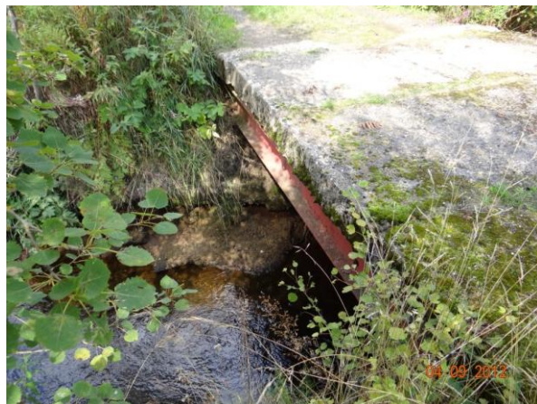
Detail mostovky, může dojít k záchytu splávní.
