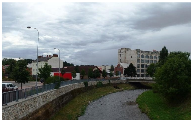
Obr. 7 – Ochranné prvky u filiálky: nábrežní zeď a břehová komunikace na Opavě (vlevo; Palickap, CC BY-SA 4.0, Wikimedia Commons) a pohled z mostu na areál (vpravo; © Google Street View). Při Q50 a vyšších průtocích dochází k přelití břehu s komunikací.
