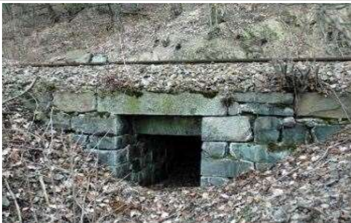
Příklady realizace propustků pod liniovými komunikacemi (VUT Brno)
