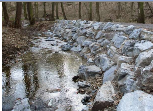
Stabilizace náporového břehu u komunikace z velkých kamenů (zdroj: HL. město Praha)
