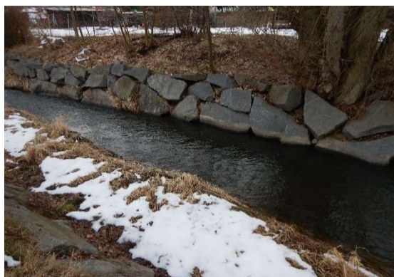
Kamenná rovnánina na Litavce v intravilánu Příbrami (foto: Sweco Hydroprojekt)
