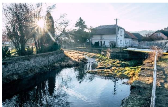
Ochranné zdi - obec Komárov (zdroj: VRV, a.s.)
