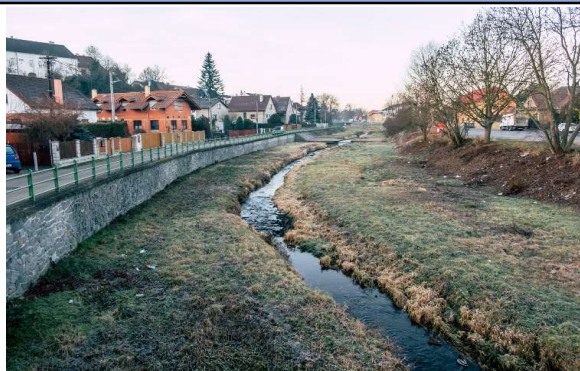
Ochranné zdi - obec Horovice (zdroj: VRV, a.s.)
