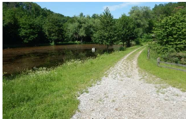
Pohled na hráz rybníka Pekárek na Švarcavě ve Stř. kraji (foto: Sweco Hydroprojekt)
