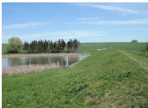
Suchá nádrž s malým objemem stálého nadržení - Prušánky (foto: Sweco Hydroprojekt)
