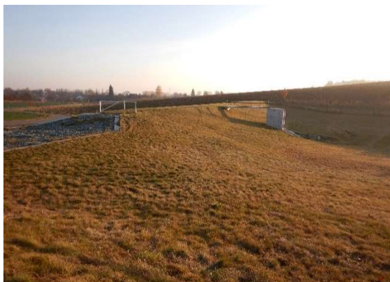
Pohled na hráz SN Ronov u Hradce Králové (foto: Sweco Hydroprojekt)
