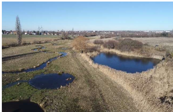
Neprůtočné tůně v rámci revitalizace Říčanského p. v Praze (foto: Sweco Hydroprojekt)
