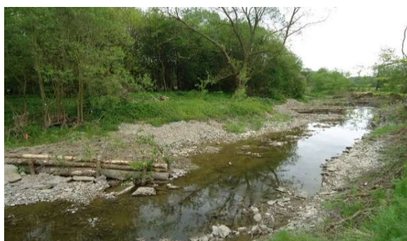
Možné iniciační zásahy dřevěnými výhony na toku Prudník (zdroj: Povodí Odry s.p.)
