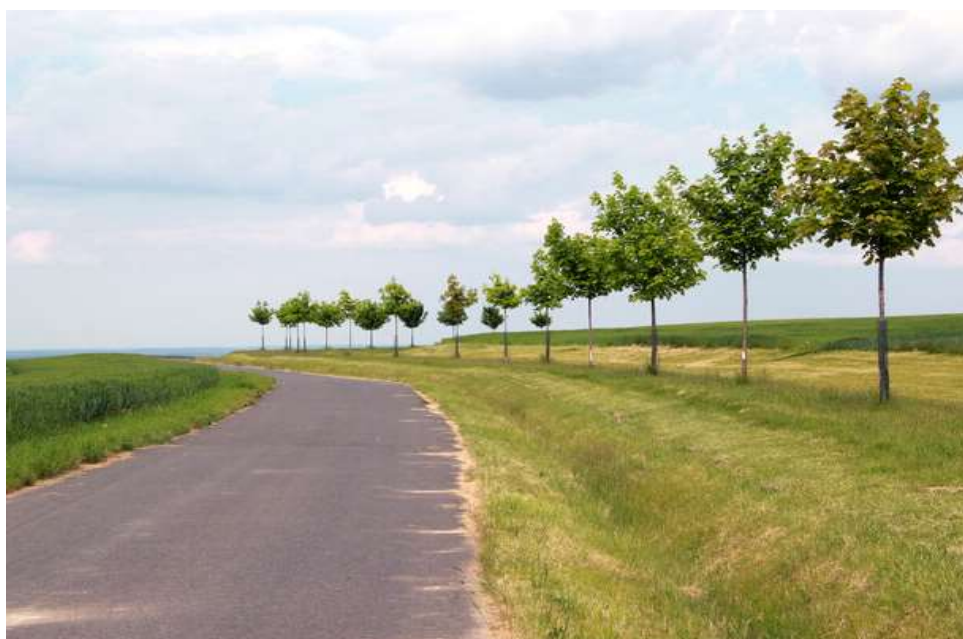
Polní cesta s protierozní funkcí, travním pásem a liniovým stromořadím vybudovaná v rámci KoPÚ v Červených Pečkách (zdroj: ekolist.cz)
