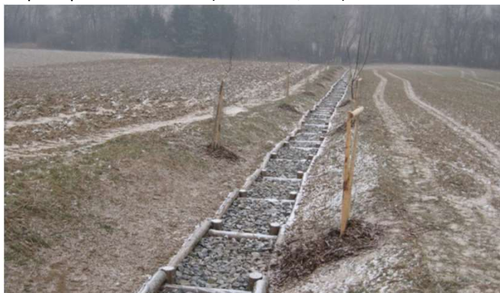
Svodný zpevněný příkop v k.ú. Lhotka u Zlína (VÚV TGM, v.v.i)
